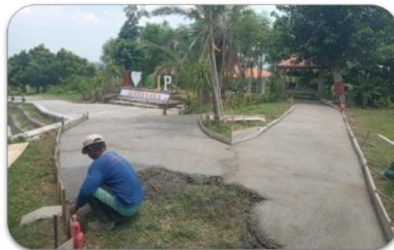
Gambar 11. Pembangunan area ikon pada akhir tahun 2020
