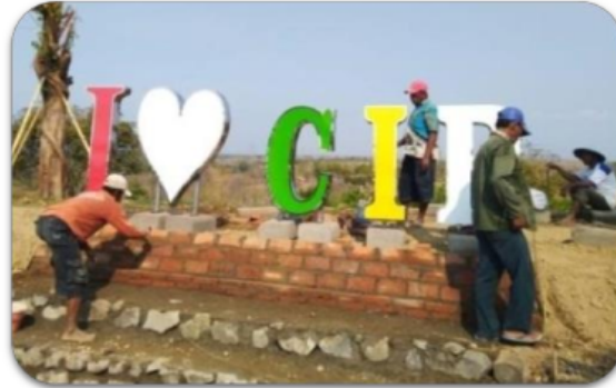
Gambar 10. Pembangunan ikon “CIP” pada akhir tahun 2019
