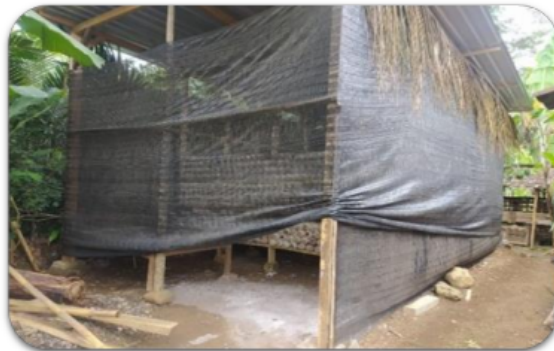
Gambar 4. Pembuatan kumbung 1 jamur tiram
