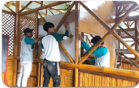
Gambar 1. Pembangunan perpustakaan RA Darul Izzah
