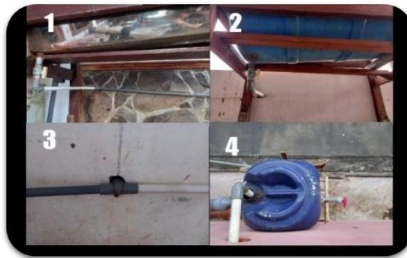
**Gambar 3.** Instalasi per bagian sistem IPAL dengan metode presipitasi dan filtrasi untuk kelompok UMKM batik Kendedes Dusun Randutelui
