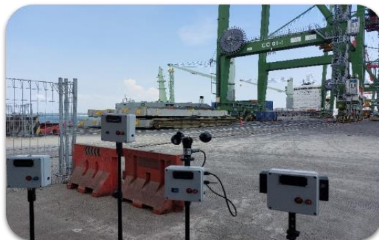
Gambar 4. Kegiatan instalasi perangkat keras monitoring kebisingan di dermaga TTL
