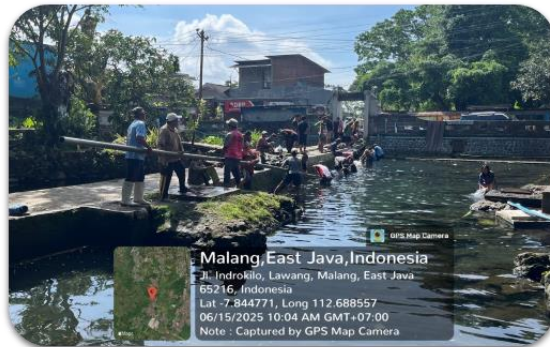
Gambar 4. Pemasangan pipa induk, perbaikan jaringan air bersih
