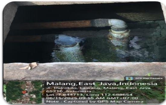
Gambar 3. Pengambilan data sumber air dan pemeriksaan infrastruktur air
