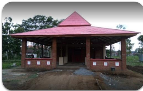
Gambar 4. Bangunan dapur dan ruang makan
