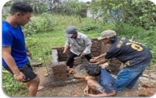
Gambar 1. Proses pembentukan rocket stove
