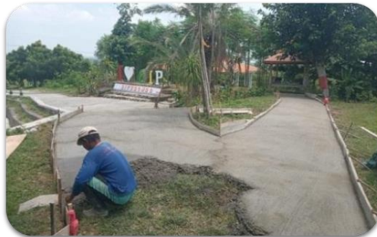
Gambar 11. Pembangunan area ikon pada akhir tahun 2020
