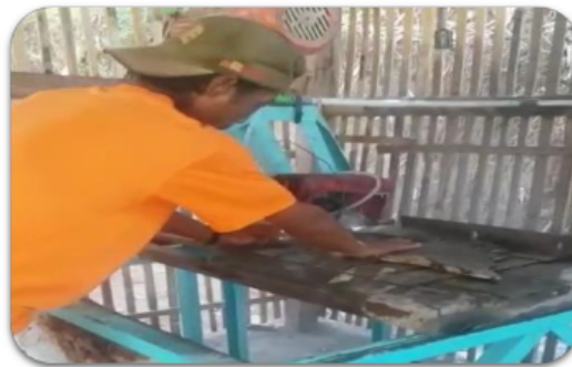
Gambar 7. Pemasangan rangka dan mesin yang telah dimodifikasi
