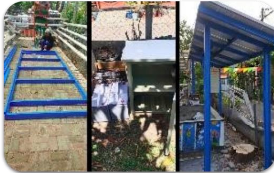
Gambar 5. Proses instalasi pembangkit listrik tenaga surya (PLTS) yang dipasang di KRPL Segaran Asri.
