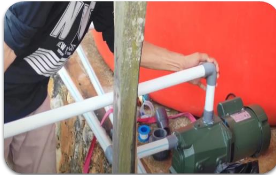
Gambar 3. Kegiatan perbaikan infrastruktur pipa
