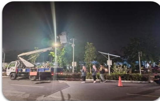
Gambar 7. Proses instalasi pemasangan dan konfigurasi alat
