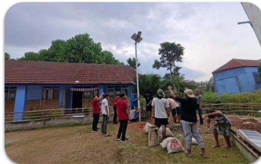
Gambar 4. Proses pemasangan panel surya di jalan desa
