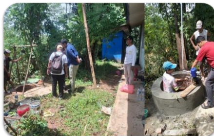
Gambar 11. Proses penggalian dan pembuatan sumur
