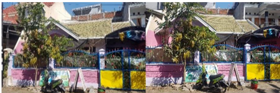
Gambar 3. Tampilan gedung TAUD yang baru
