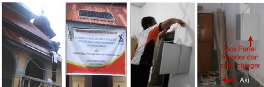
Gambar 3. Pemasangan panel surya dan kotak panel kontrol
