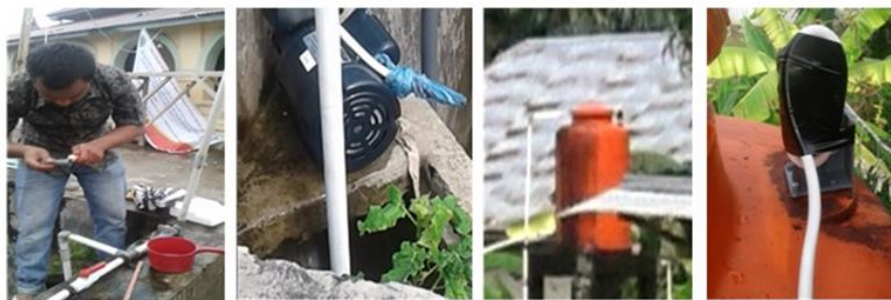
Gambar 4. Pemasangan pompa dan sakelar apung
